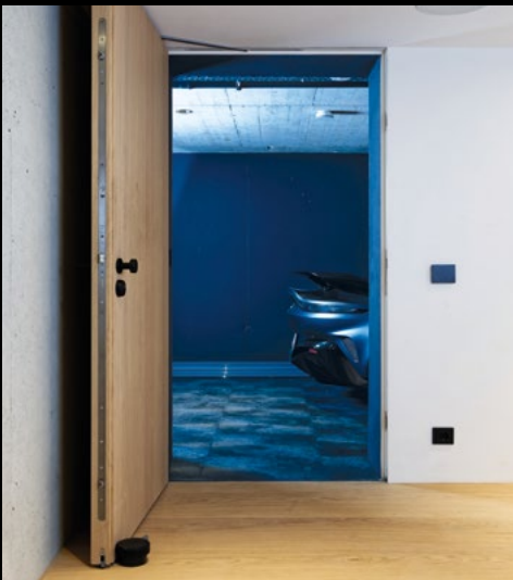
Brandschutz-Tür zur Garage
