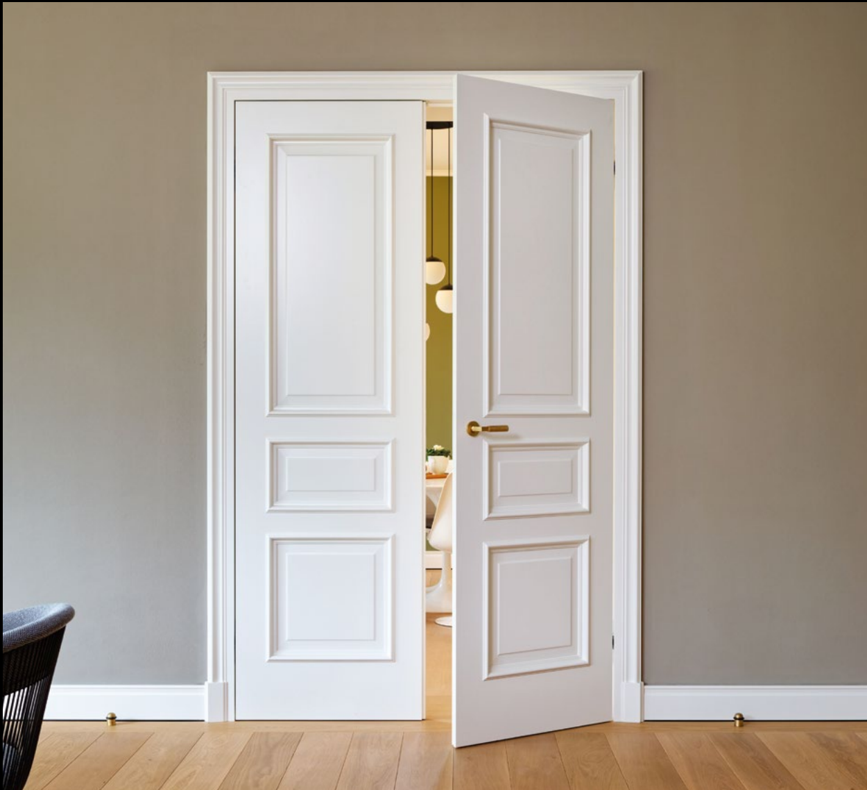
Zweiflügeliges Türelement mit profilierten Bekleidungen und Basenklötzen
