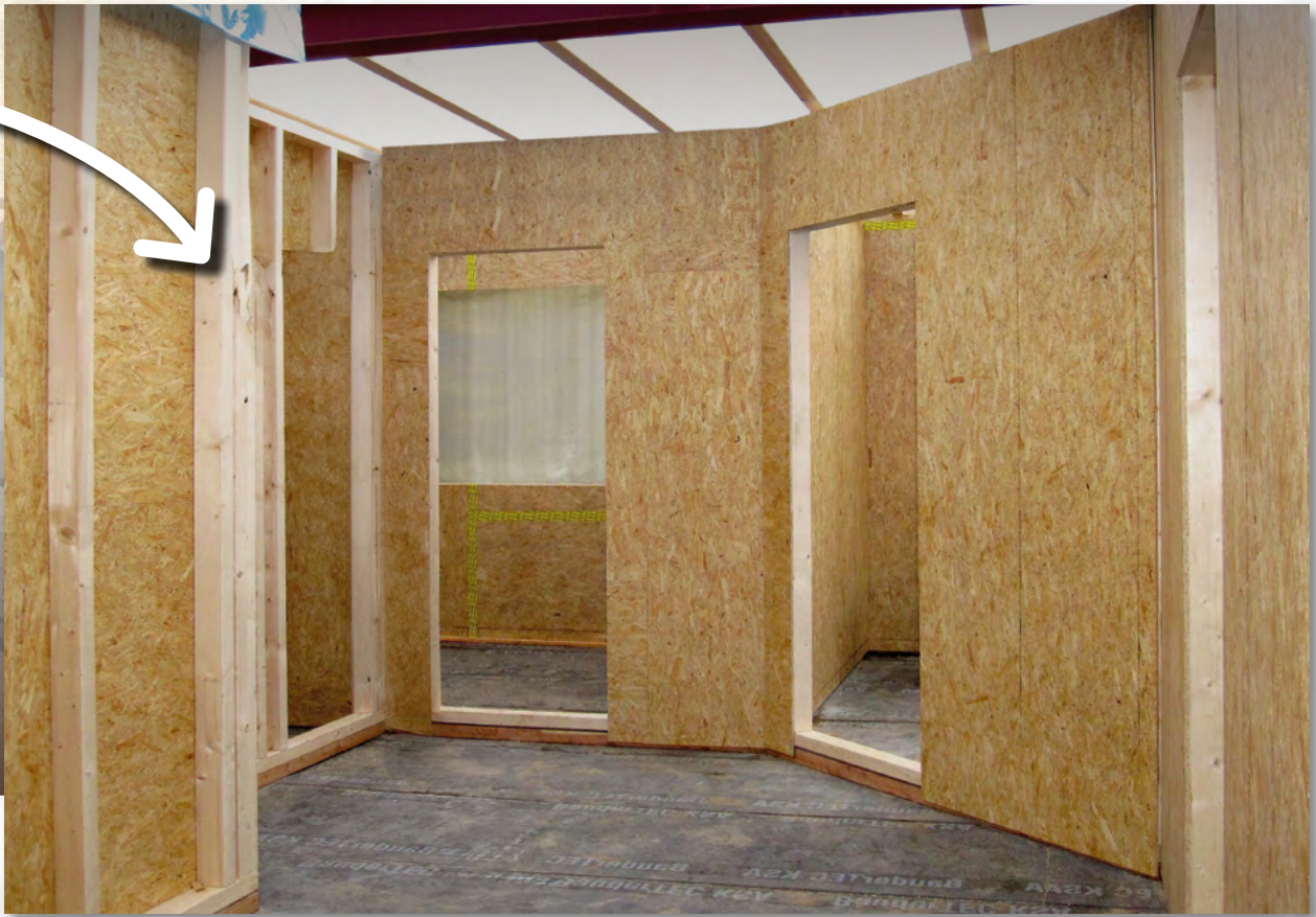
Vorgefertigte Wandelemente auf der Baustelle
