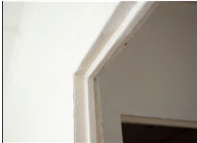
Typische Wandsituation im Plattenbau
