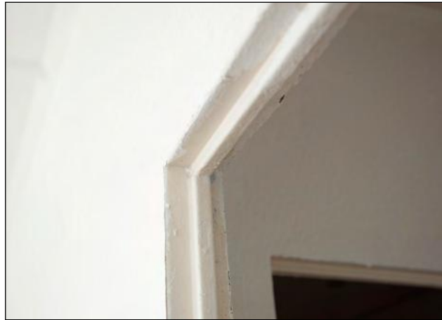
Typische Wandsituation im Plattenbau
