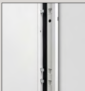
Bandseitige Bolzen
