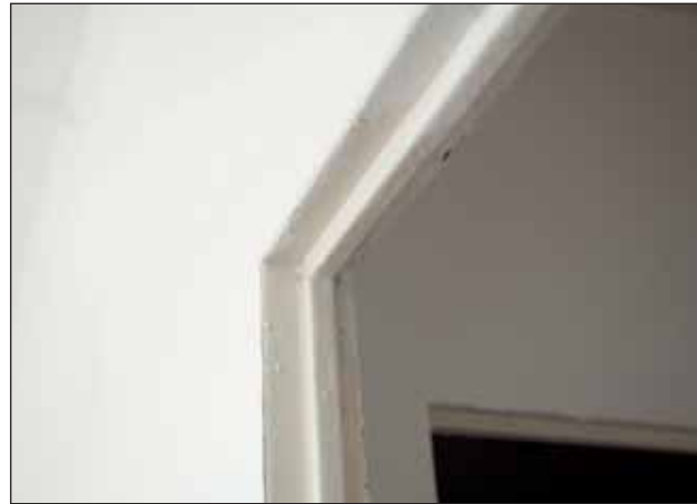
Typische Wandsituation im Plattenbau
